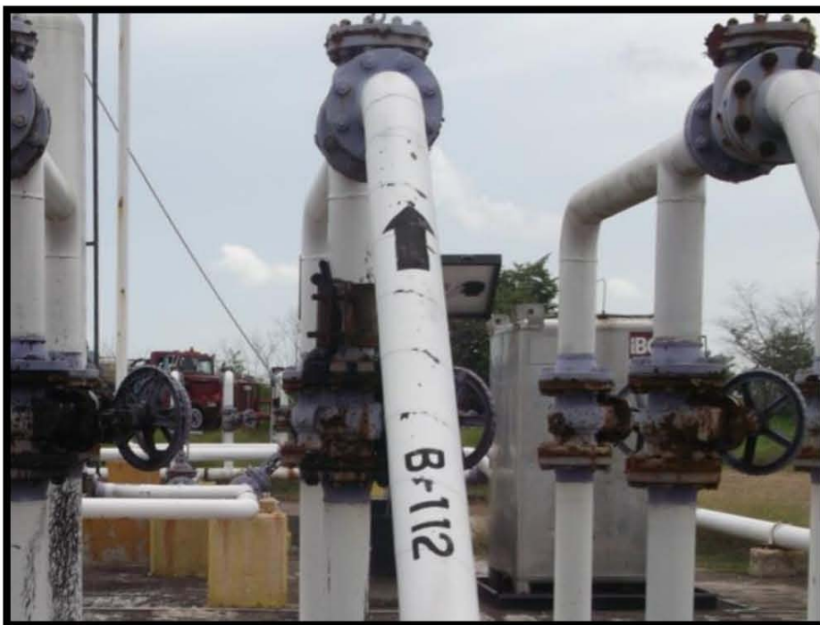
Fotografía 9.- Presencia de grapa en colector de línea de recolección del Pozo Barcodón 112, aguas bajo de válvula check.
