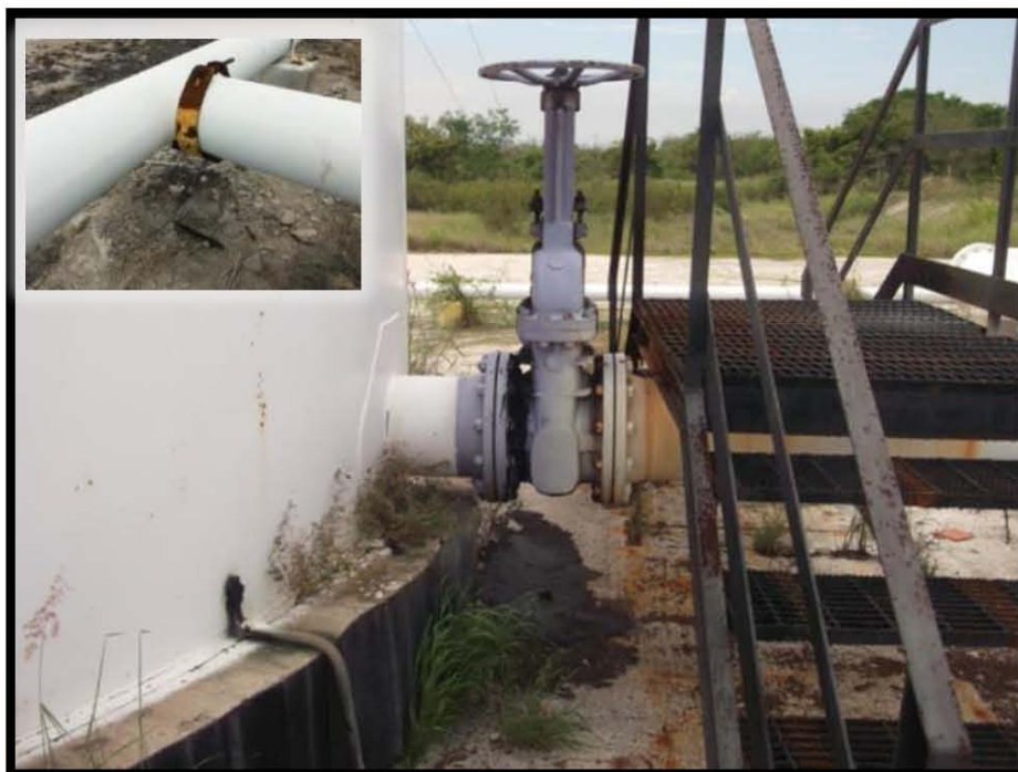
Fotografía 15.- Filtración y corrosión en válvula de tipo compuerta. Presencia de grapa provisional en tubo de salida de tanque de almacenamiento TV-176.
