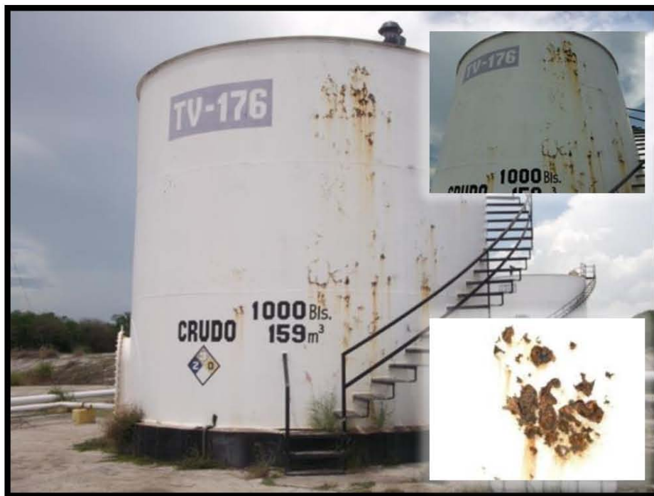
Fotografía 14.- Tanque TV-176 con presencia de corrosión, falta de pintura y mantenimiento general.
