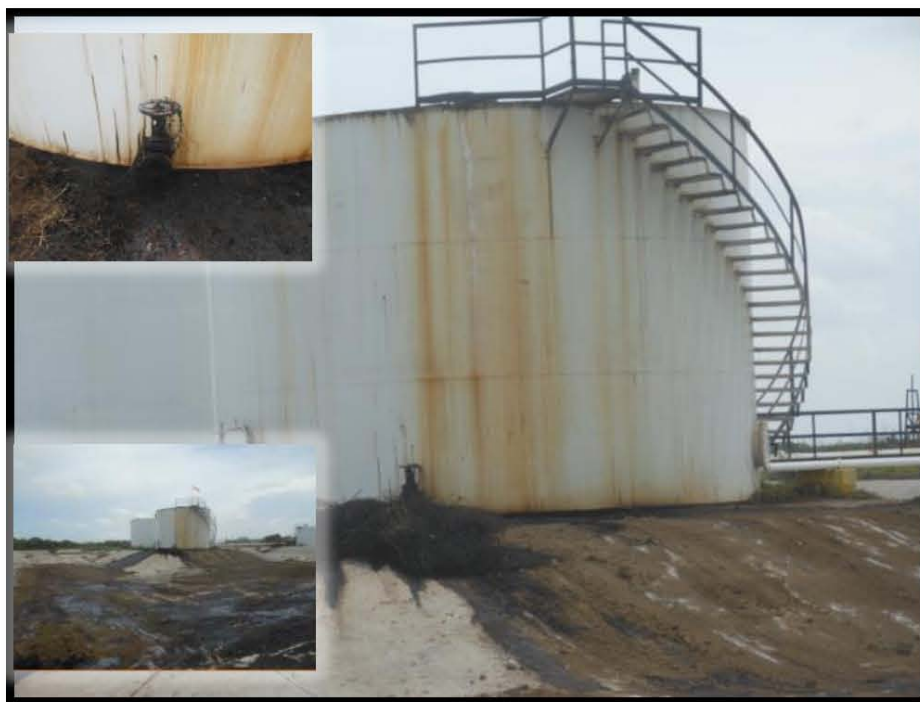
Fotografía 17.- Se realizan trabajos de limpieza en dique de contención por derrame en tanque TV-174.
