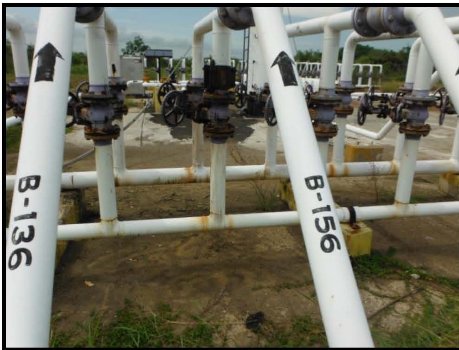
Fotografía 10.- Presencia de grapa en colector de línea de recolección del Pozo Barcodón 156, aguas debajo de válvula check.
