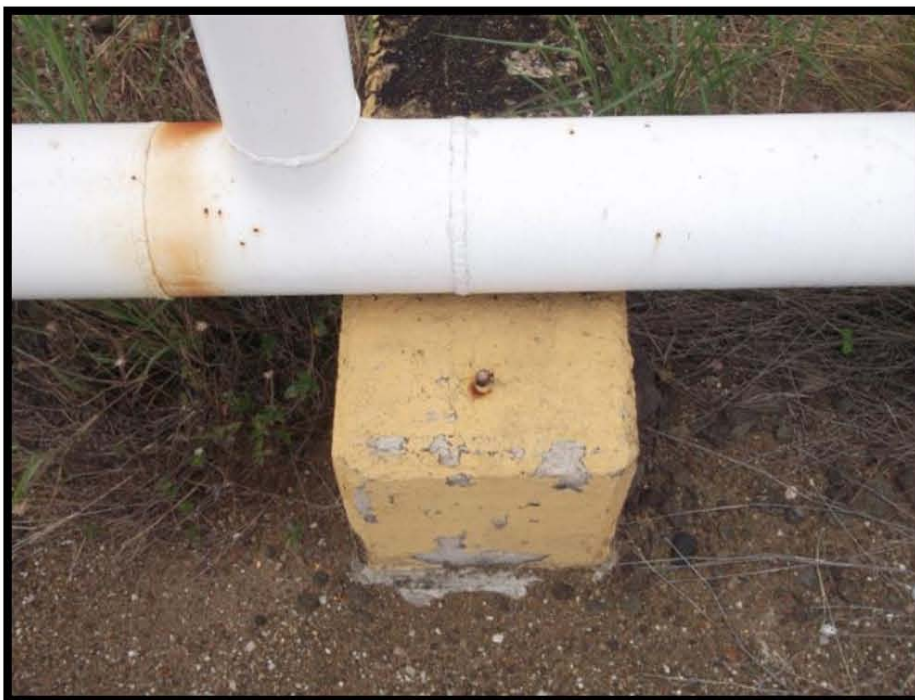
Fotografía 7.- Falta de omegas en colector de líneas de descarga, residuo peligroso en periferia de colector.
