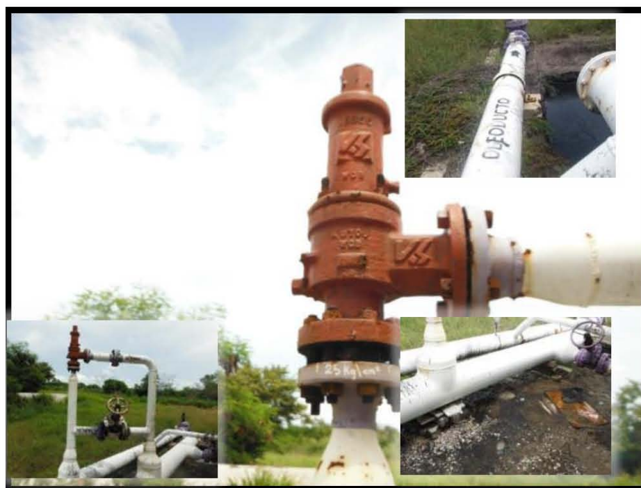
Fotografía 20.- Falta de Mantenimiento y corrosión en válvula de seguridad, uso de calzas inadecuadas para ducto.
