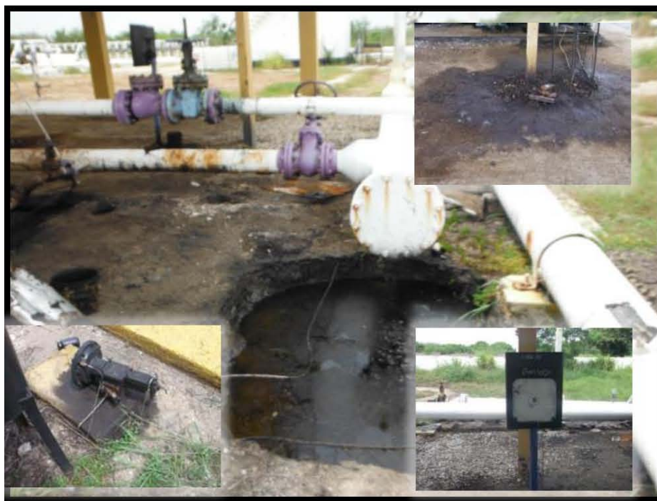
Fotografía 21.- Excavación con agua y trazas de hidrocarburo, filtración en bomba texsteam.
