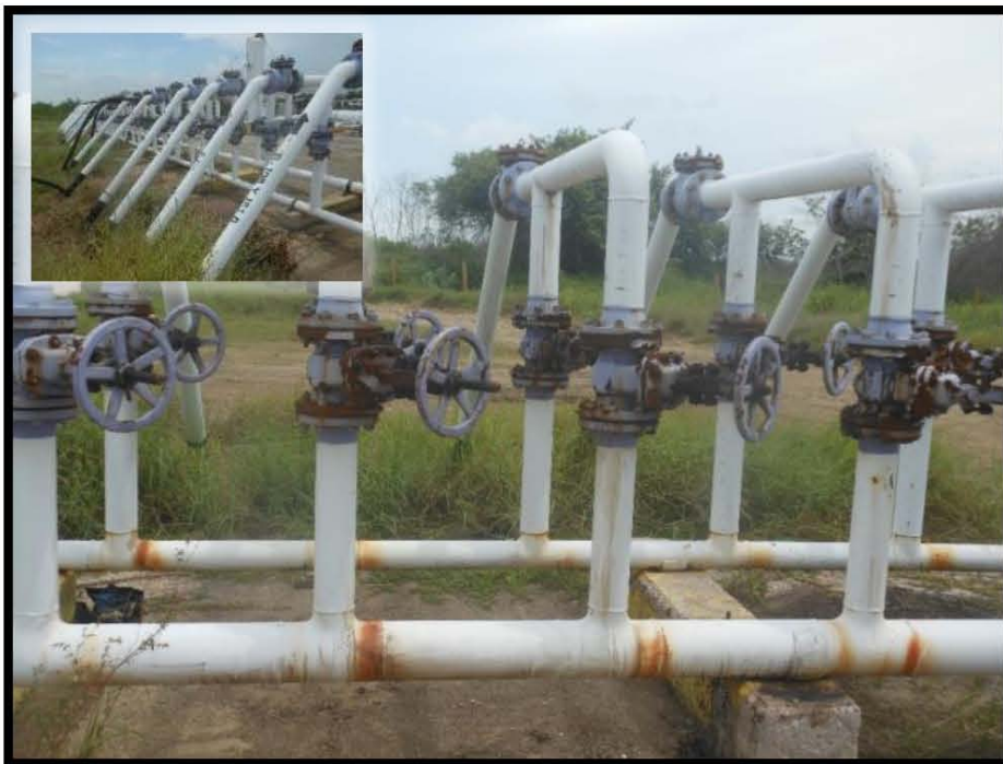
Fotografía 8.- Corrosión en válvulas tipo macho, en llegadas de líneas de recolección.
