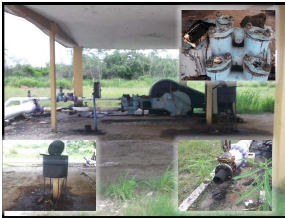
Fotografía 18.- Área con manchas dispersas de hidrocarburo falta de tapón roscado en tubería.
