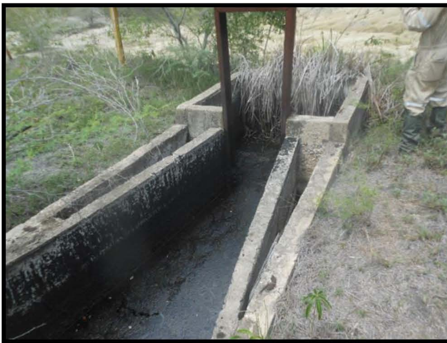
Fotografía 5.- Cárcamo con agua con trazas de hidrocarburo, lado este de la Batería de Separación.
