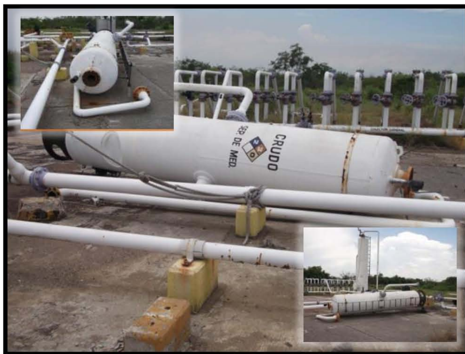
Fotografía 12.- Separador vertical de medición desconectado y abandonado.
